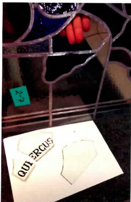
Senieji vaistinės vitražai buvo restauruoti ir sudėti į naujai pagamintus stiklo paketus. Aivaro Tamašausko nuotr.
