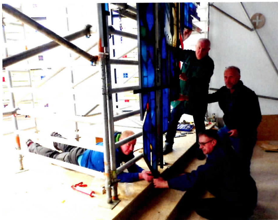
Vitražo montavimo darbai.
